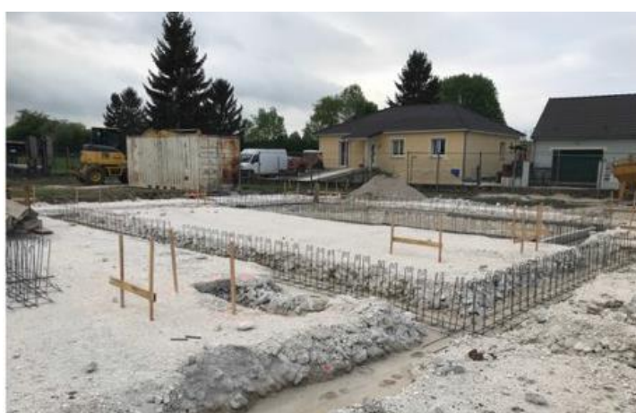
Réalisation des Fondations
