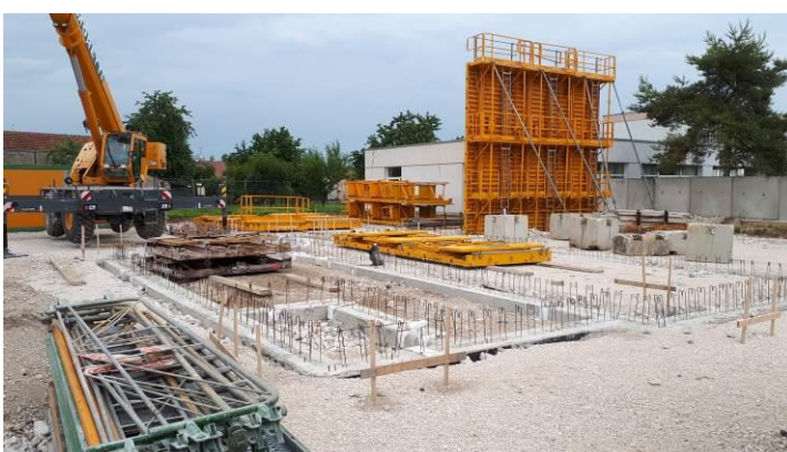
Montage des coffrages
