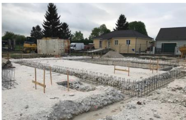
Réalisation des Fondations
